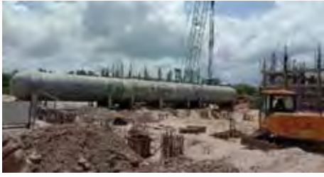
4.5मी. व्यास x 50मी. लंबाई का (संख्या 6) वायु संग्रहण पात्र का स्थल उत्पादन
